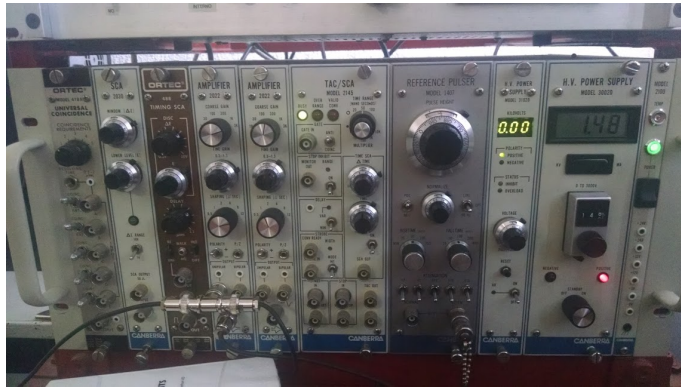
Figura 6: El rack, donde están los aparatos de amplificación y las fuentes de alta tensión.
