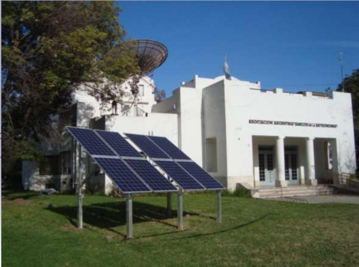
Instalación piloto de 2 kW conectada a la red interna del Observatorio de la Ciudad de Buenos Aires en el Parque Centenario.
