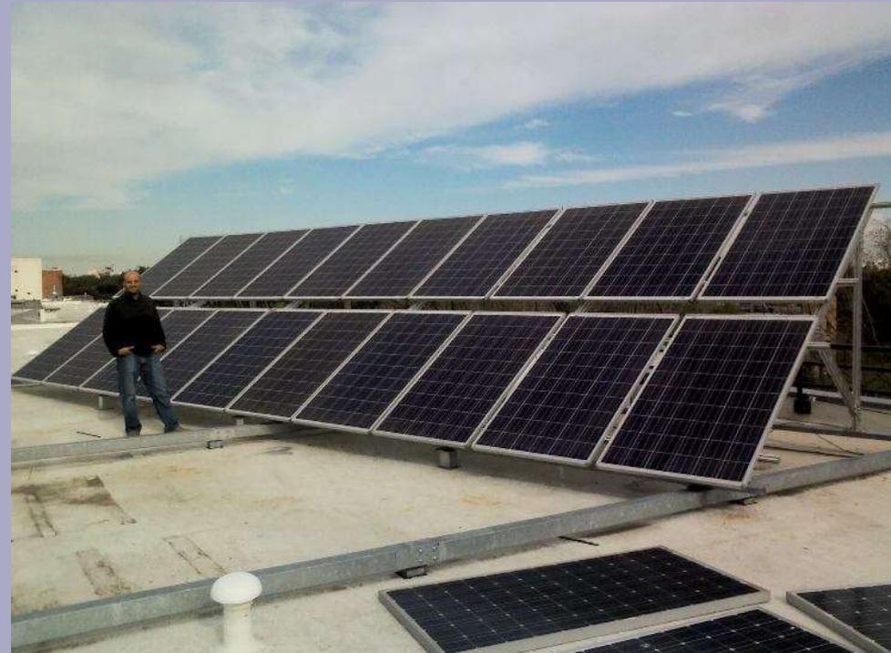
Sistema fotovoltaico instalado en la terraza del Tandar. Veinte módulos FV de 240 Wp c/u. Potencia total 4.7 KW
