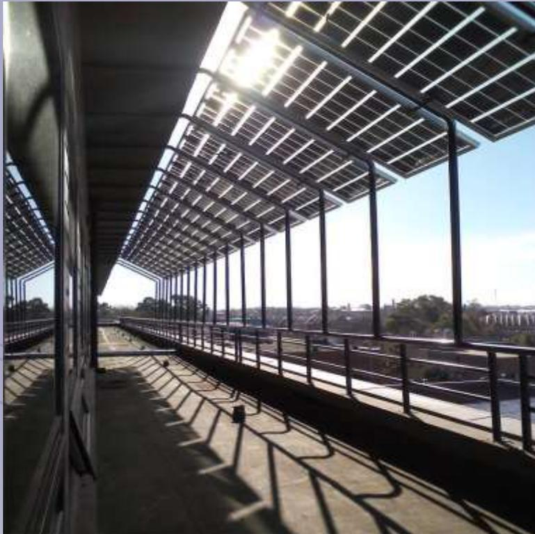
Pérgola fotovoltaica instalado en el balcón del tercer piso del Tandar. Veintitrés módulos FV de 235 Wp c/u. Potencia total 4.9 KW
